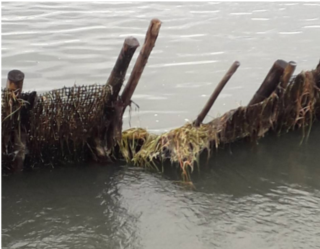
Φωτ. 1. Ζημιές στον ιχθυοφραγμό των ιχθυοτροφείων Κόμμα Σχοινιάς (15-11-2019).
