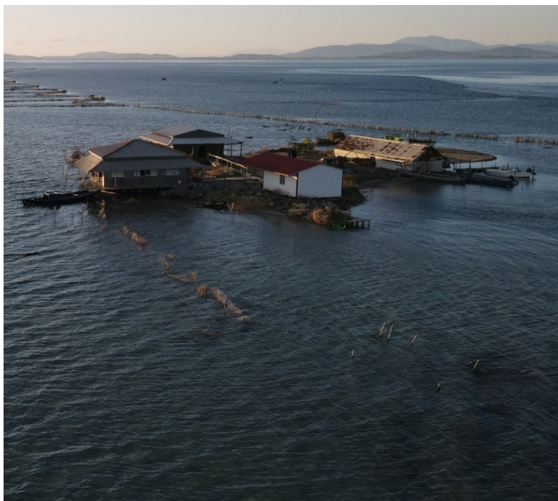
Φωτ. 5. Νησίδα ιχθ/φείου Κόμα με κατεστραμμένη εξέδρα πρόσδεσης σκαφών.
