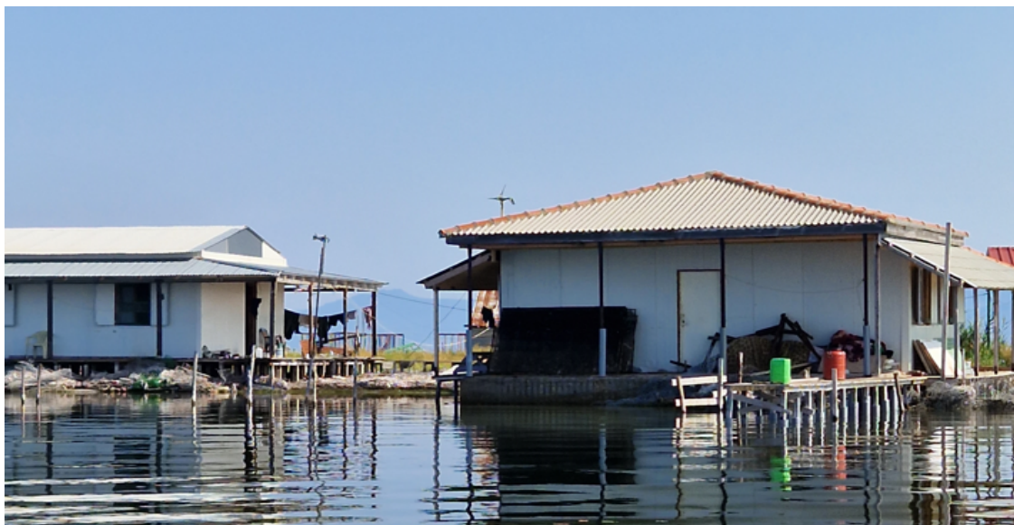
Φωτ.2. Άνω: Ζημιές στους οικίσκους διαμονής και εργασίας του προσωπικού από την σφοδρή κακοκαιρία της 30 ης Νοεμβρίου 2021, κάτω: Οι οικίσκοι μετά την αποκατάσταση των ζημιών και τη βελτίωσή τους.
